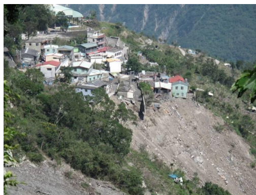
(b) 災後下邊坡區域崩塌影像
